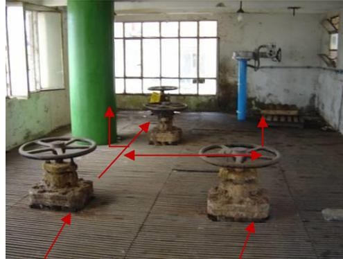
Hay un total de 3 bombas Kaplan, una de álabes fijos, y dos de álabes regulables, encontrándose bajo las mismas, las válvulas de aspiración e impulsión, que funcionan hidráulicamente.
