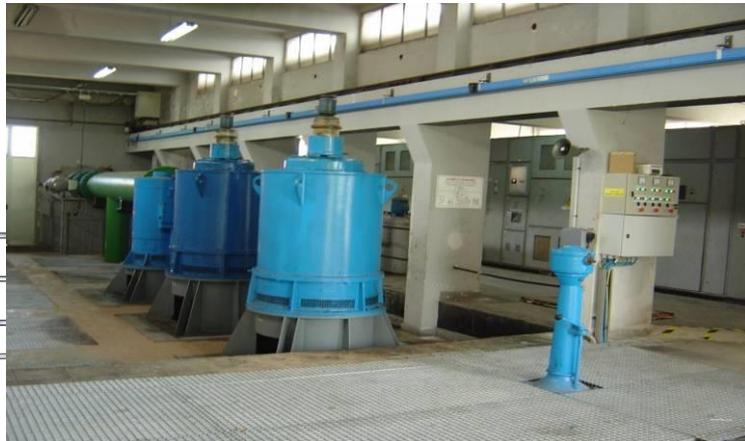
Las bombas disponen de dos velocidades de trabajo: 750 rpm y 1000 rpm, siendo el caudal efectivo de 600 l/seg y 850 l/seg, respectivamente.
