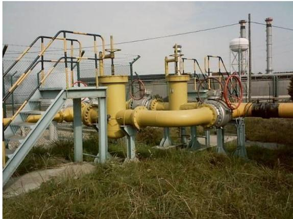
**PREFILTROS.** Dos filtros idénticos montados en paralelo situados en el exterior de la sala con válvula de esfera anterior y posterior al filtro, que retienen partículas de polvo de tamaño superior a 5 micras, y que incorporan un manómetro de presión diferencial para comprobar el estado de saturación. Sólo una de las líneas de prefiltrado está en red, permaneciendo la otra cerrada.
