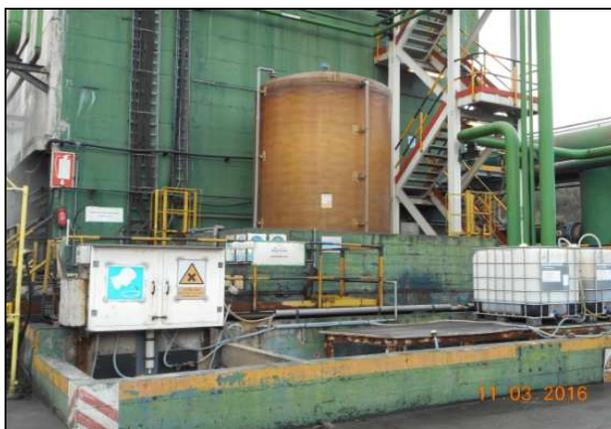
Depósito vertical en PRFV y resina antiácida vinilester Atlas 430, para almacenamiento de hipoclorito sódico, de 30000 litros de capacidad, situado en un único cubeto de retención. Dimensiones 2900 x 4843 mm
