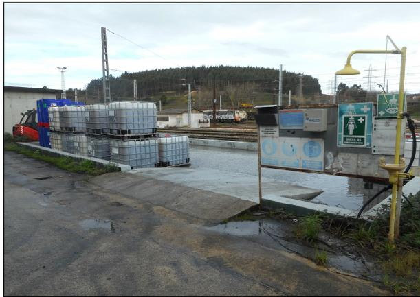
GRGs con reactivos, fundamentalmente biocidas, anti-incrustantes y otros productos para aplicación en las instalaciones de tratamiento de agua. Suelo de hormigón, resistentes a estos productos, con peralte para contener un posible vertido.
