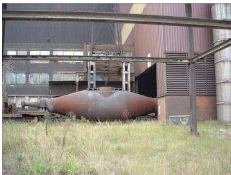
Recepción de arrabio en vagones torpedo
