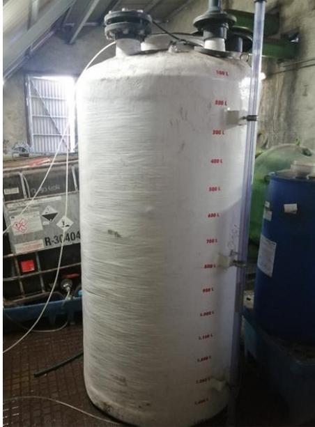
Depósito vertical FPL cerrado cilíndrico vertical de fondo plano, construido en poliéster reforzado con fibra de vidrio de 1,5m<sup>3</sup> de capacidad de doble pared especial para contener hipoclorito al 18% a presión atmosférica y temperatura ambiente. Diámetro 1000x1600 mm. De altura total, acabado exterior en color blanco.
