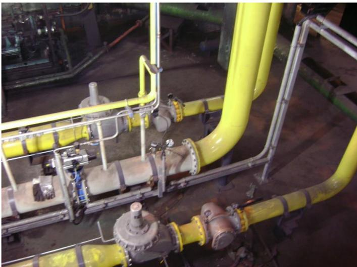
Las tuberías de los lados son las bajantes a sendas válvulas RM. Tubería central es subida a colector general.
