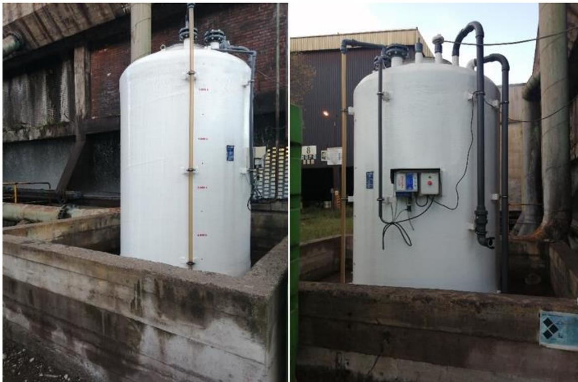
Deposito vertical FPL cerrado cilíndrico vertical de fondo plano, construido en poliéster reforzado con fibra de vidrio de 5m<sup>3</sup> de capacidad de doble pared especial para contener hipoclorito al 18% a presión atmosférica y temperatura ambiente. Diámetro 1600x2470 mm. De altura total, acabado exterior en color blanco.
