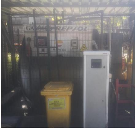
Tanque aéreo de doble pared, para almacenamiento de combustible en el EXTERIOR de la nave industrial. Será cilíndrico, con fondos abombados y con una capacidad nominal de 5.000 litros. Las medidas de este depósito son:
