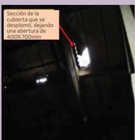
Sección de la cubierta que se desplomó, dejando una abertura de 400x700mm
