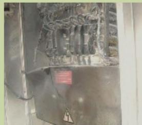
Daños en un armario eléctrico de un centro de control de motores, causados por un fusible defectuoso
