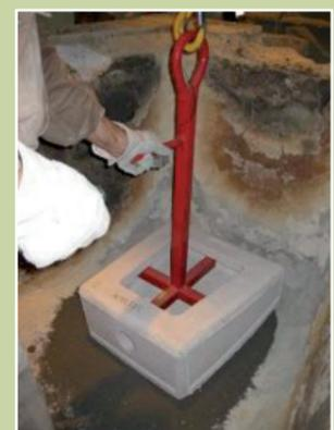
Actualmente: nuevo dispositivo de izado que permite realizar el ajuste sin contacto directo con la pieza.
