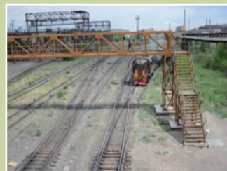
Pasarela peatonal construida sobre las vías en Temirtau (Kazajstán).
