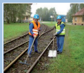
Ejemplo de mejores prácticas: los operadores comprueban que las zonas adyacentes a las vías estén despejadas y libres de baches o desniveles, para eliminar el riesgo de tropiezo o caída.
