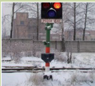
Paso a nivel correctamente señalizado.
