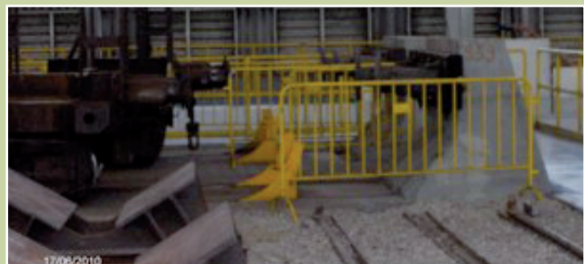
Vallas amarillas que impiden el acceso a la zona de los topes de la vía.
