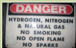
Ejemplo de señalización adecuada. Se indica claramente la presencia de gases y las normas que deben aplicarse.
