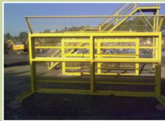
Sistema de protección para la descarga de camiones (Productos largos América).
