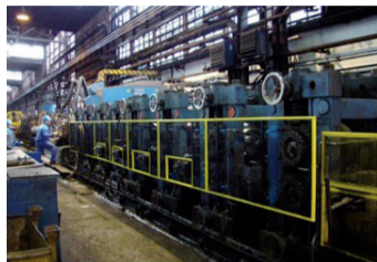
Protección contra riesgos derivados de la energía cinética en la planta de Productos Tubulares en Karvinà (República Checa).
