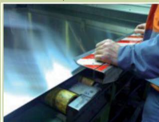
Reposamanos instalado para reducir el riesgo de contacto con la chapa.
