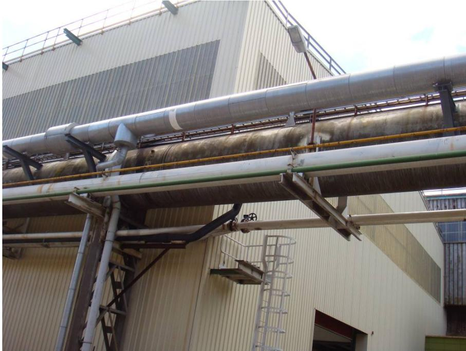
Ilustración 3. Tuberías de Gas, Agua, Amoniaco.
