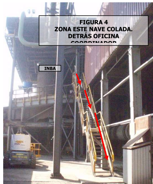
Figura 4: En la parte este de la nave de colada, detrás de la oficina del coordinador, hay una vía de evacuación hacia cota cero.
