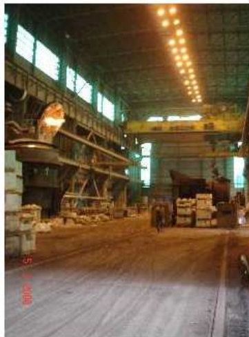
Nave de reparación de cucharas
