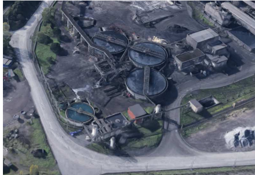
Tratamiento de aguas
