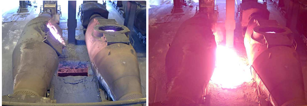
Planchada de convertidores (carga, soplado, y sangrado/desescoriado)
