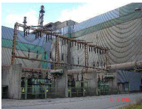
Transformadores 132/6,6 KV
