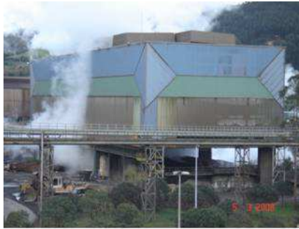
Nave de escoria
