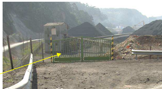
Detalle acceso lado norte
